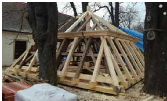
Netradiční oprava střechy Taverny
