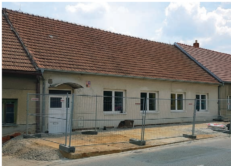
Budova ZUŠ před demolicí
