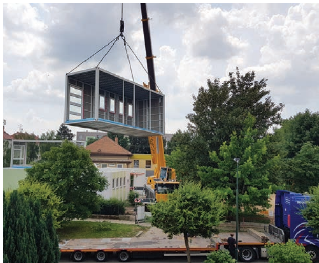
Nástavba MŠ ve vzduchu
