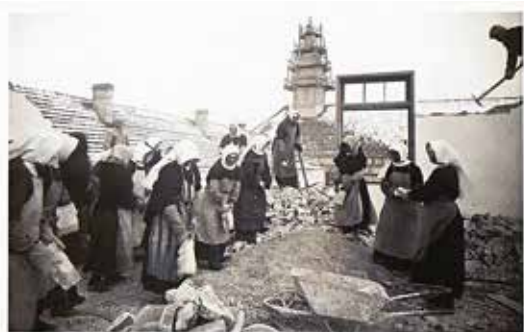
Oprava kláštera po válce
